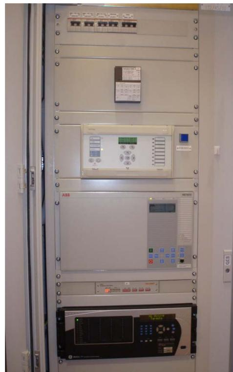
Figura 9. Armario de control y protección de línea AT
