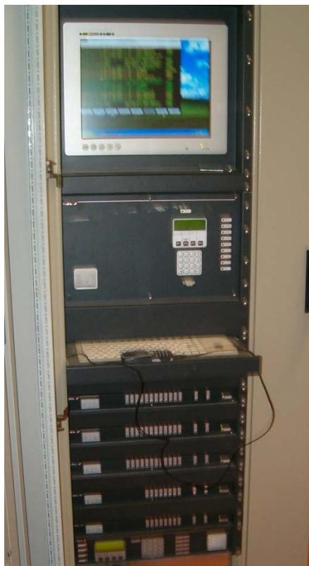
Figura 10. Unidad Central de Subestación.
