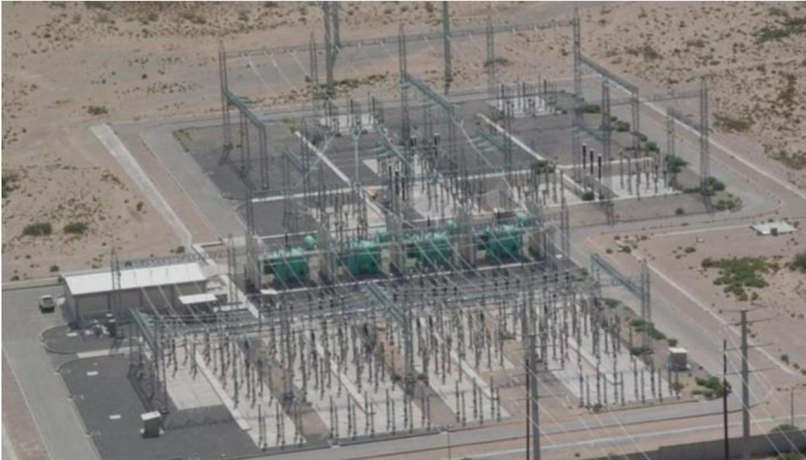
*Figura 2. Subestación intemperie convencional*
