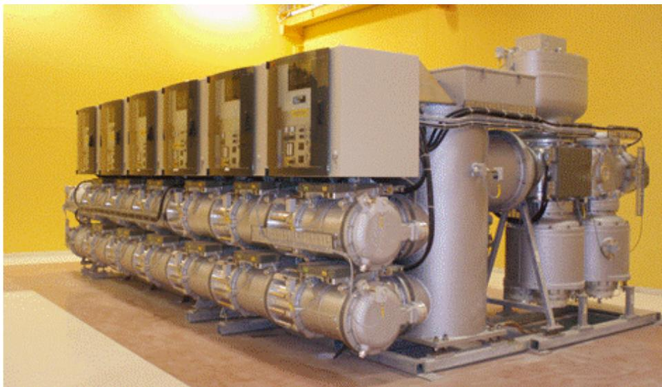
*Figura 3. Parque AT. Celda aislada en gas SF6 GIS*
